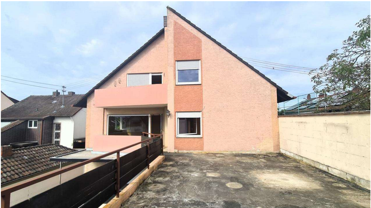
OG hinten Dachterrasse
