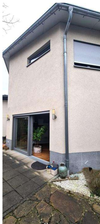
Ansicht hinten Terrasse
